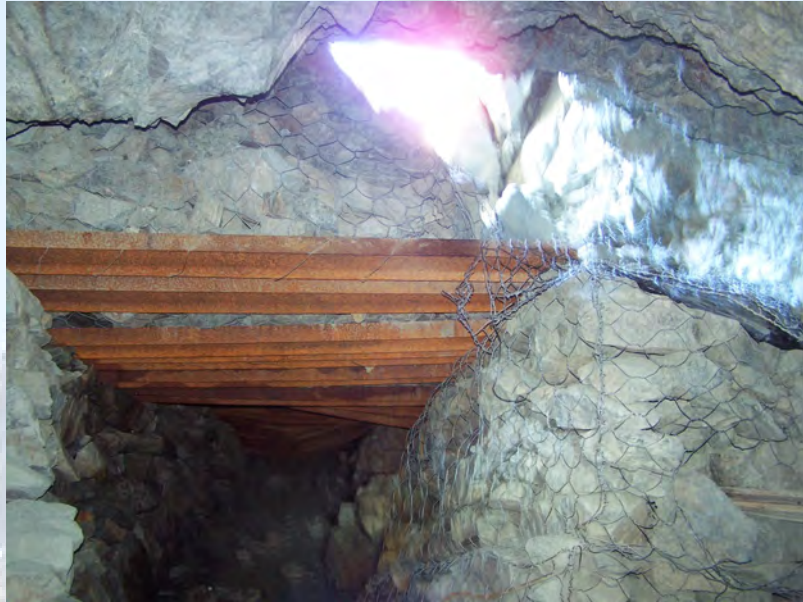
Particolare del passaggio prima dell'intervento di riapertura del tunnel
