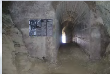
A fine lavori arco di entrata in pietra naturale sul lato francese e punto di innesto del tunnel artificiale
