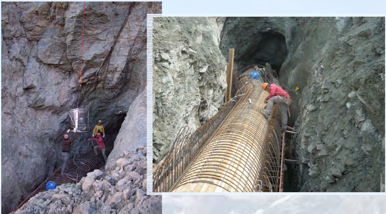
Fasi dei lavori di messa in sicurezza
