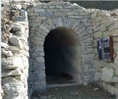
A fine lavori arco di entrata in pietra naturale sul lato francese e punto di innesto del tunnel artificiale
